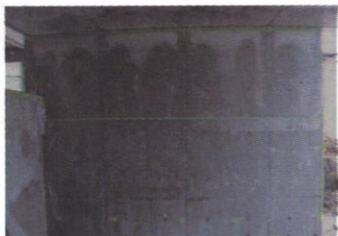
上／型枠解体後の養生期間を湿潤に保つため、壁面にシートを張り、乾燥を防止。「岩瀬式」の特徴の一つ
