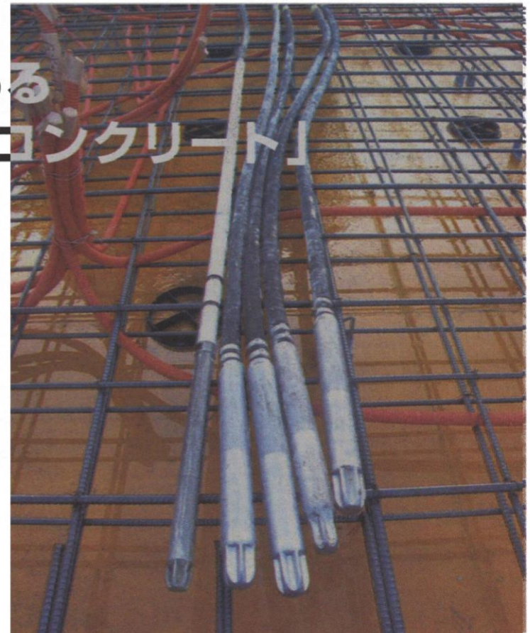
生コン打設後と再振動の際、壁面型枠の底部までパイプレーターを挿入するため、長柄のもの(左端)を使います
