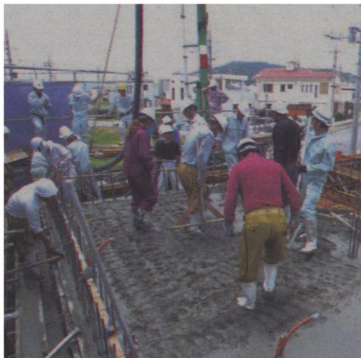
スラブ面の打設では、一度ならした面を再度踏み固め密実にし、生コンのかさが減る分を速やかに補充
