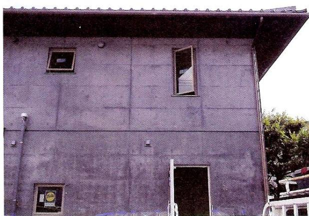
スランプ12cmの生コンを打ち込んだRC造の住宅。入念に施工すれば、硬い生コンでもきれいに仕上がる
